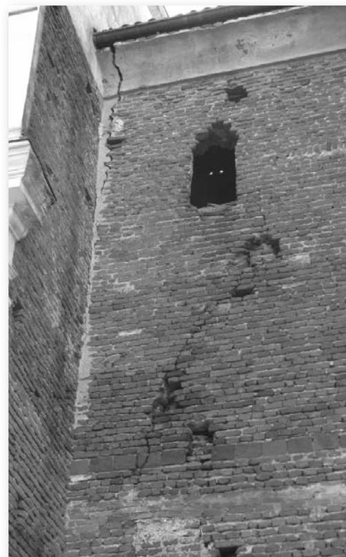
pressione con malte a base calce compatibili con la muratura in mattoni della chiesa, fino a saturare interamente le perforazioni realizzate in facciata. Noi tecnici affidiamo all'intervento eseguito il compito di bloccare ed impedire l'aggravamento del dissesto strutturale in atto.
